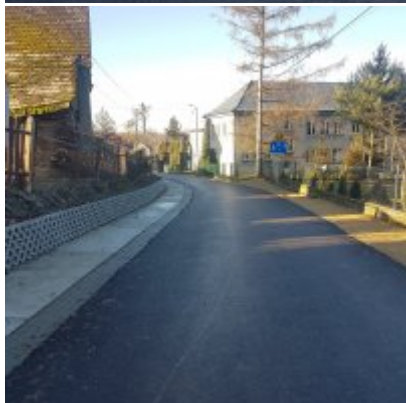
Zakończono przebudowę drogi gminnej – ul. Grabskiego
