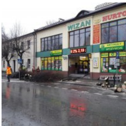
Wycinka drzew w obrębie Zatorskiego rynku
