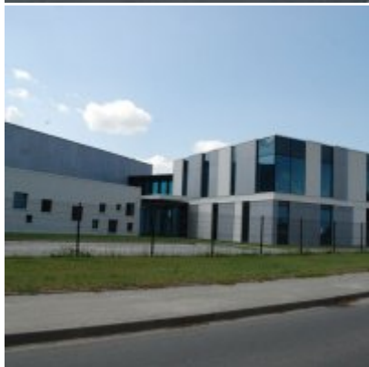
Zatorska Strefa Aktywności Gospodarczej FOTOGALERIA - czerwiec 2017
