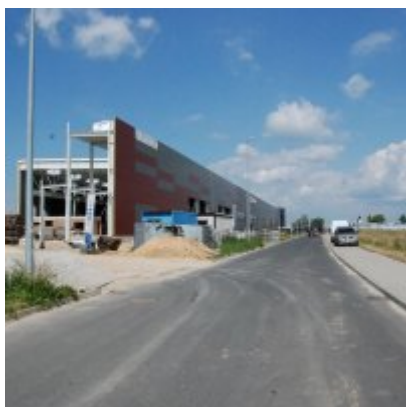
Zatorska Strefa Aktywności Gospodarczej FOTOGALERIA - czerwiec 2017
