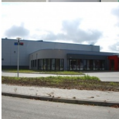
Zatorska Strefa Aktywności Gospodarczej - wrzesień 2013
